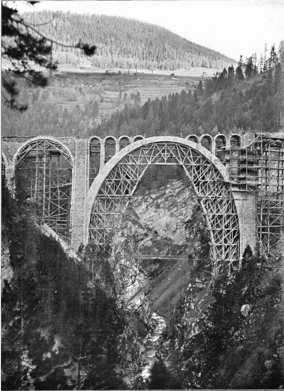
Abb. 35. Mittelöffnung des Wiesener Viadukts mit dem Lehrgerüst. — Ansicht flussabwärts.
