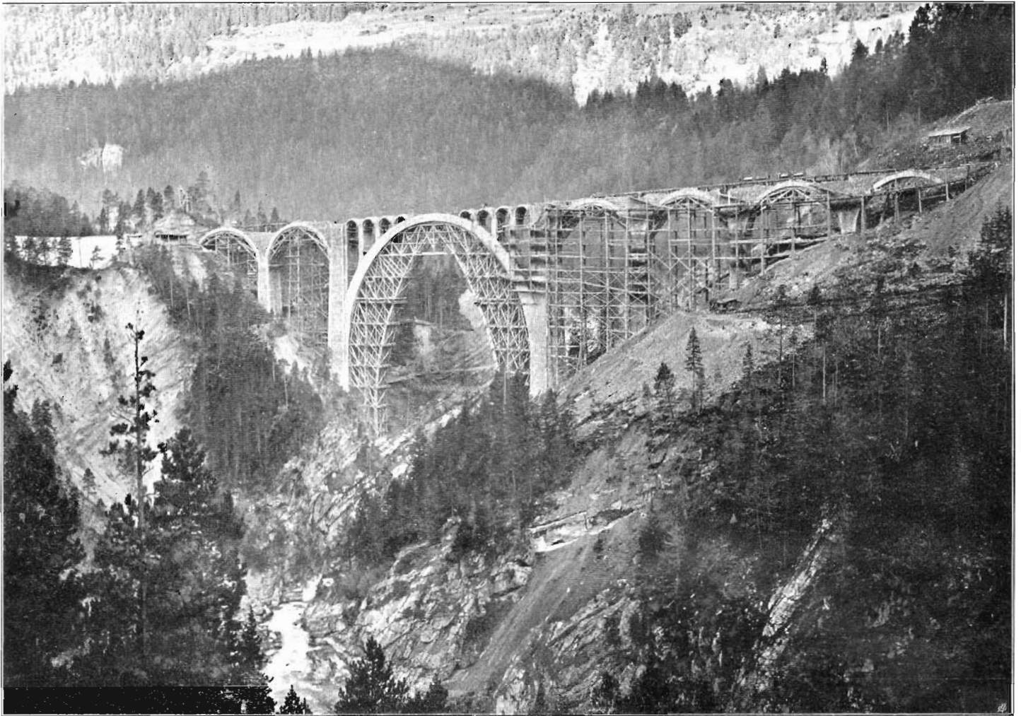
Abb. 23. a Gesamtansicht des Wiesener Viadukts von links der Bahn, flussabwärts gesehen.
