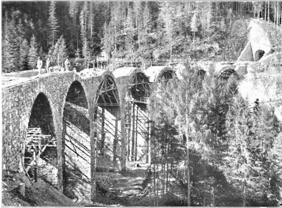
Abb. 14. Cavia-Viadukt im Bau, talwärts gesehen.
