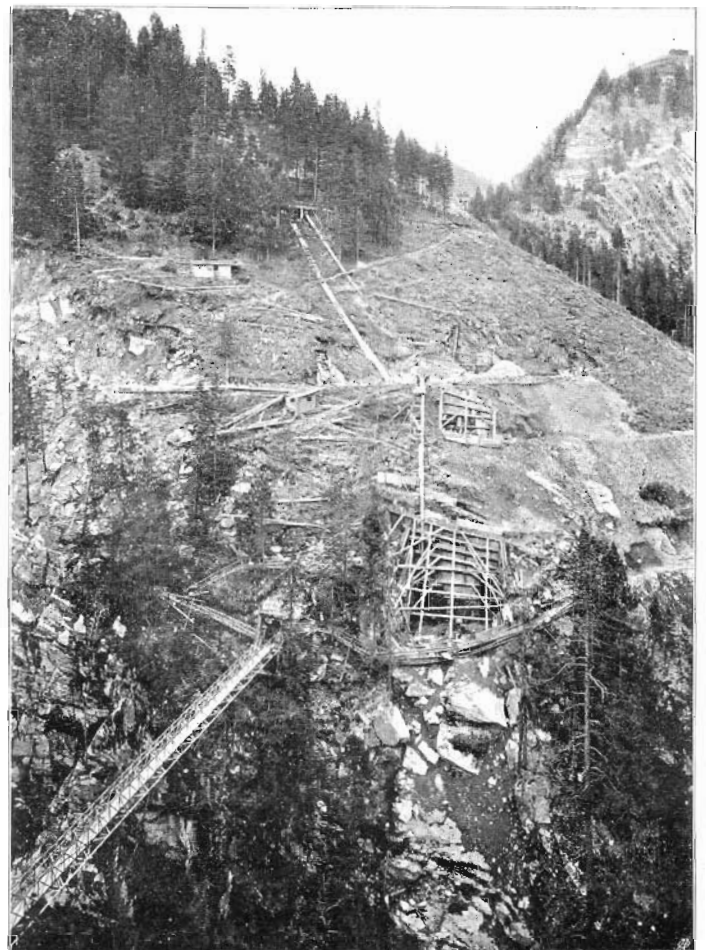
Abb. 27. Ausschachtung der rechtsufrigen Pfeiler-Fundamentgruben; provisorischer Hängesteg (masstäbl. Darstellung Bd. XLVII, S. 142).
