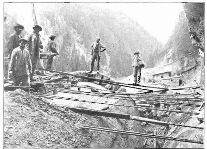
Abbildungen 8 und 9. Armierung der Steinschlag-Galerie am oberen Portal des Silberbergtunnels.
