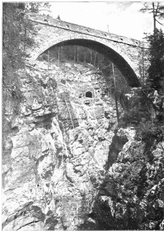
Abb. 12. Gewölbte Brücke der Zufahrtsstrasse nach Jennisberg und unteres Portal des Wiesener Tunnels II.
