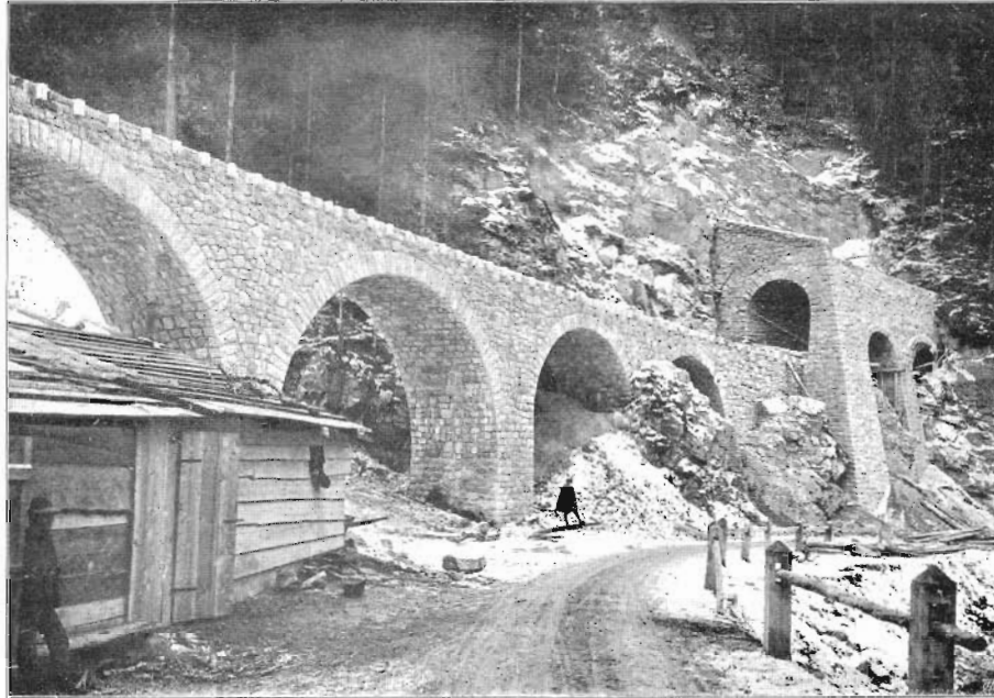
Abb. 7. Portal des Eistöbelitunnels mit Steinschlag-Galerie.
